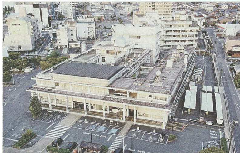
松江市役所本庁舎—松江市末次町（小型無人機で撮影）
