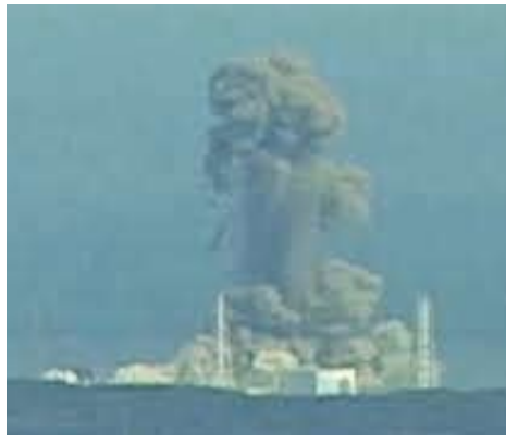
福島第一原発3号炉が水蒸気爆発した瞬間
